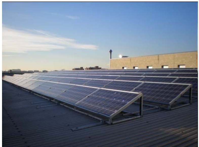
Esempio di installazione su file inclinate e distanziate
